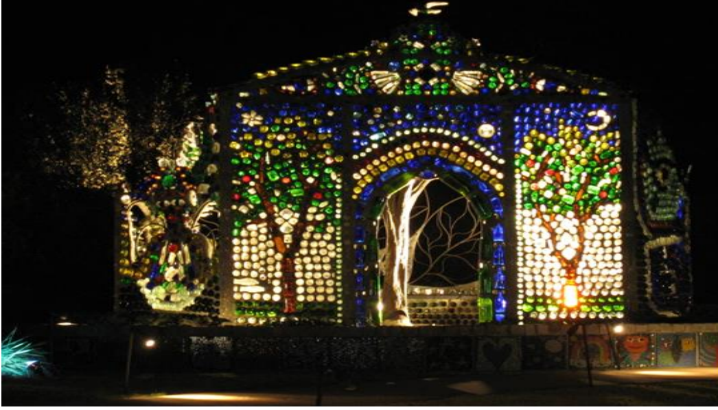
شكل (3) يوضح إستخدام القوارير الزجاجية كمواد بناء لهيكل المسكن
