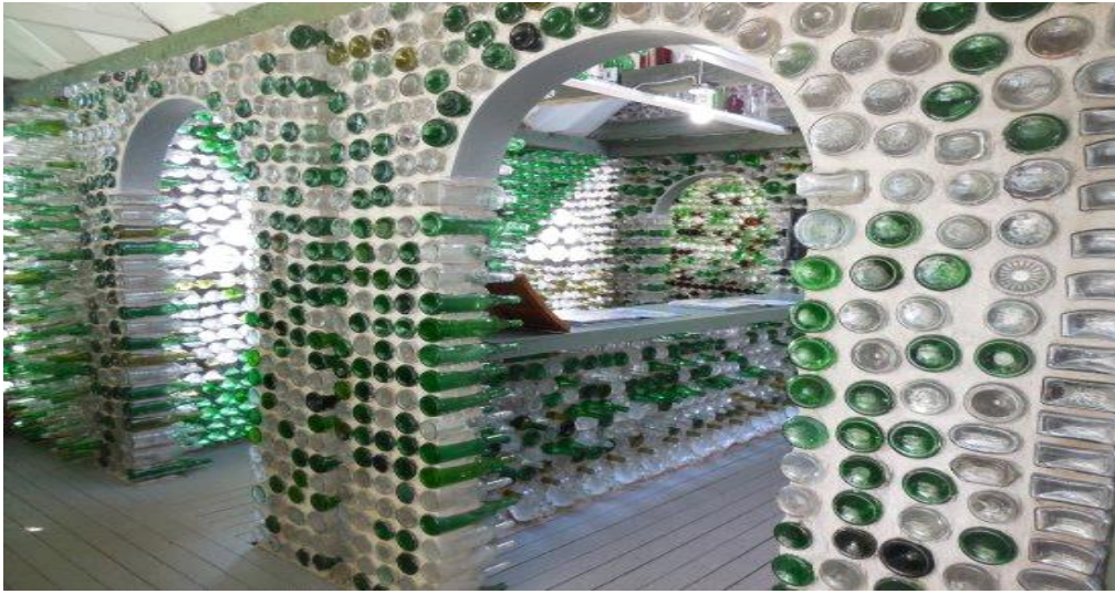
شكل (4) يوضح إستخدام القوارير الزجاجية كمواد بناء لهيكل المسكن
