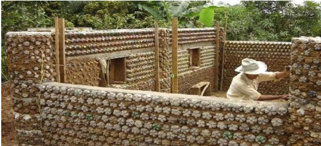
شكل (1) يوضح استخدام القوارير البلاستيكية كمواد لبناء للمسكن
