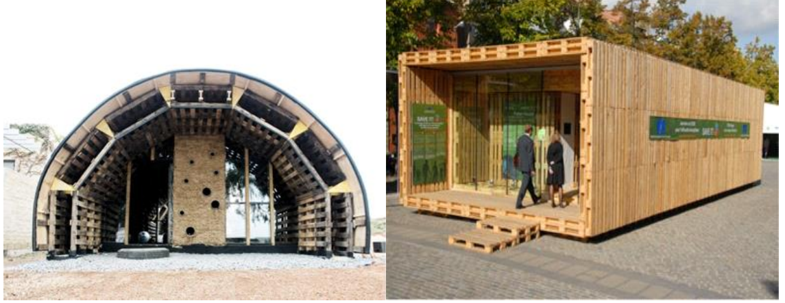
شكل (9) يوضح استخدام قواعد الشحن الخشبية في إنشاء المسكن
